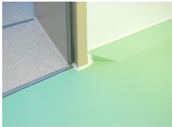
Cleanroom Floor System 2 (ableitfähig)
